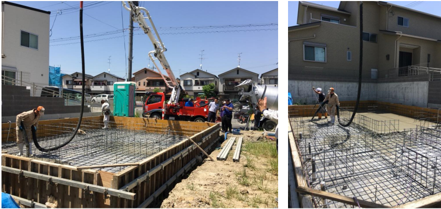
รูปที่ 27 ดูกาน Site ก่อสร้าง เป็นบ้านที่เลือกใช้ Recycle Aggregate Concrete ซึ่งคุณภาพระดับ M เทพื้น และ ระดับ H ก่อผนัง
