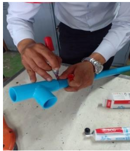
แสดงการทำเครื่องหมายที่ปลายท่อพีวีซีหลังการวัดระยะสวม
