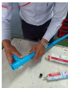
แสดงการสวมท่อและข้อต่อพีวีซีเข้าด้วยกันหลังจากทาน้ำยาประสานท่อ
